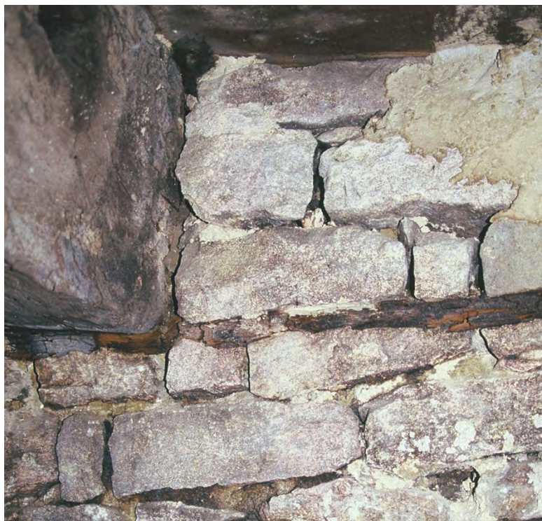
Abbildung 3.13: Haus 20, rue du Merle, Kernbau von 1091. Innenseite der Westmauer. Bauzeitliches Mauerwerk mit Mauerlatte und Deckenbalken.
