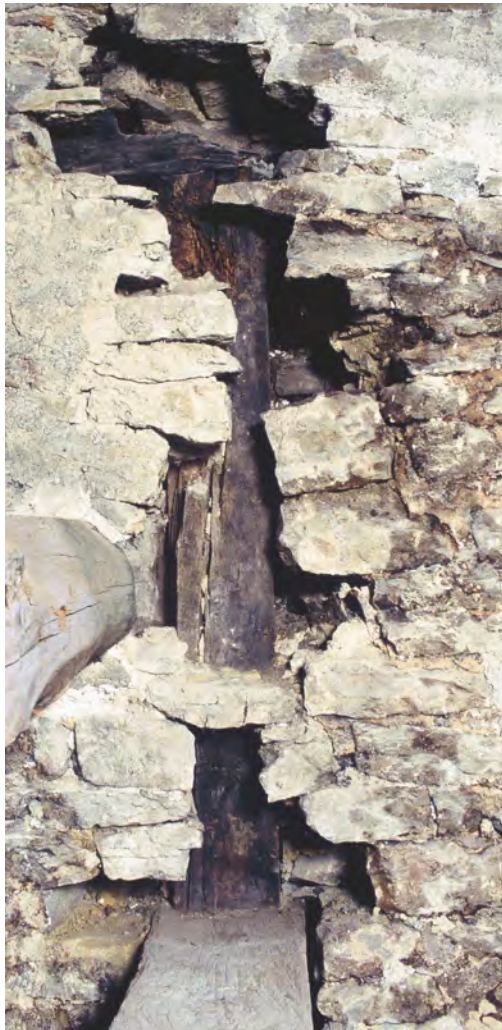
Abbildung 3.77: ‚Saalbau mit hohem Wohnhaus‘ von 1136, Dachstuhl des Saaltrakts. In der Längsmittelwand in situ vermauertes Gebinde: Dachbalken, darauf Stuhlsäule, darauf Querbalken.
