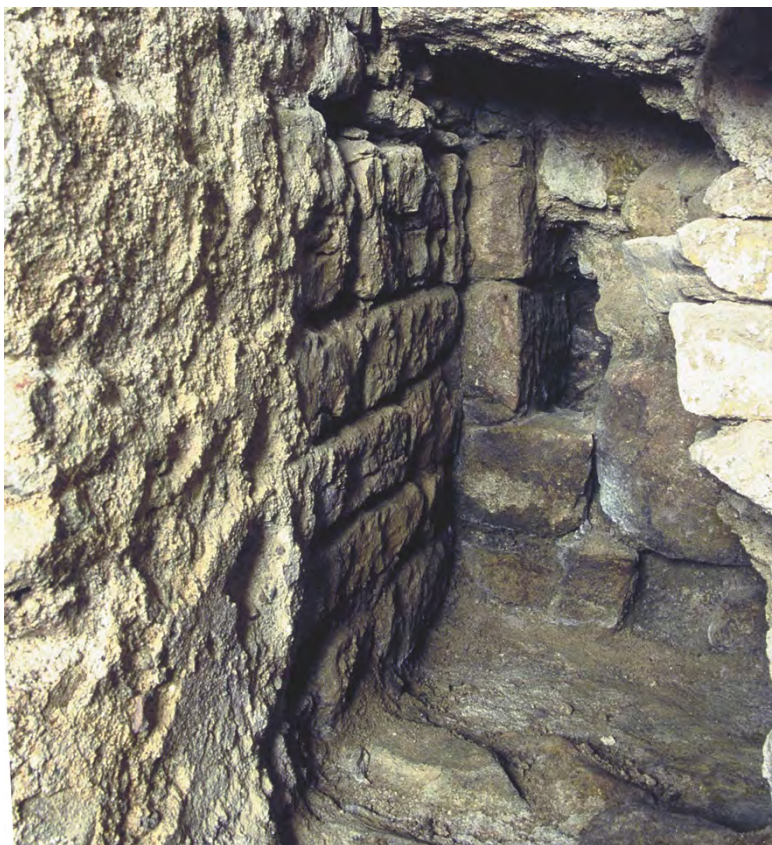
Abbildung 3.69: Sockelgeschoss, rückwärtiger Raum, Westwand.
