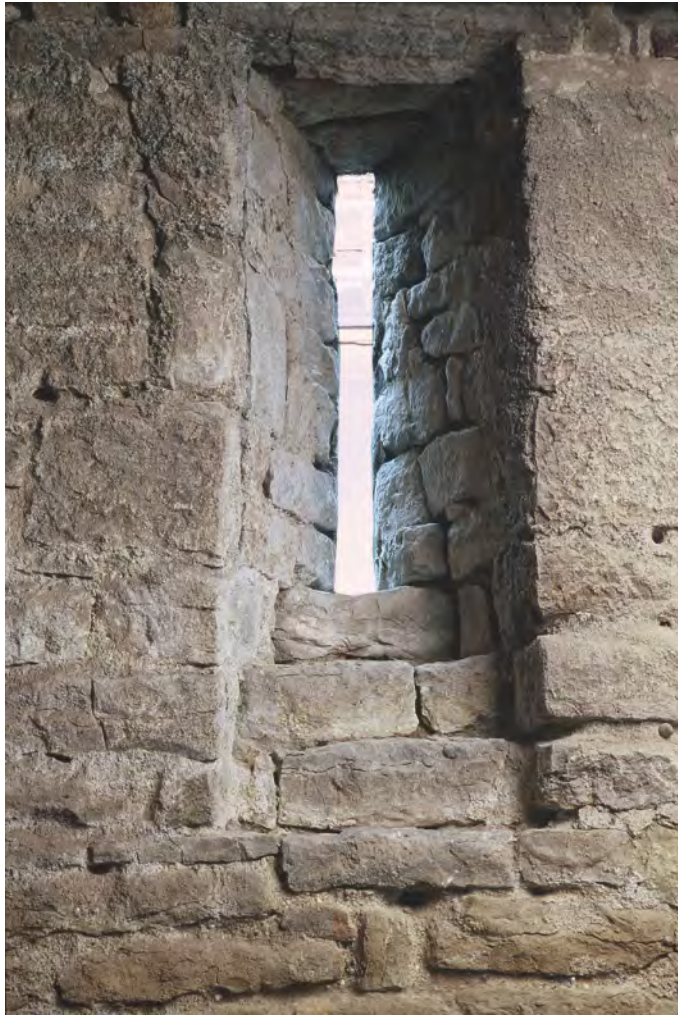
Abbildung 3.91: ‚Saalbau mit hohem Wohnhaus‘ von 1136, Westwand Sockelgeschoss. Vollständig erhaltenes Schlitzfenster.
