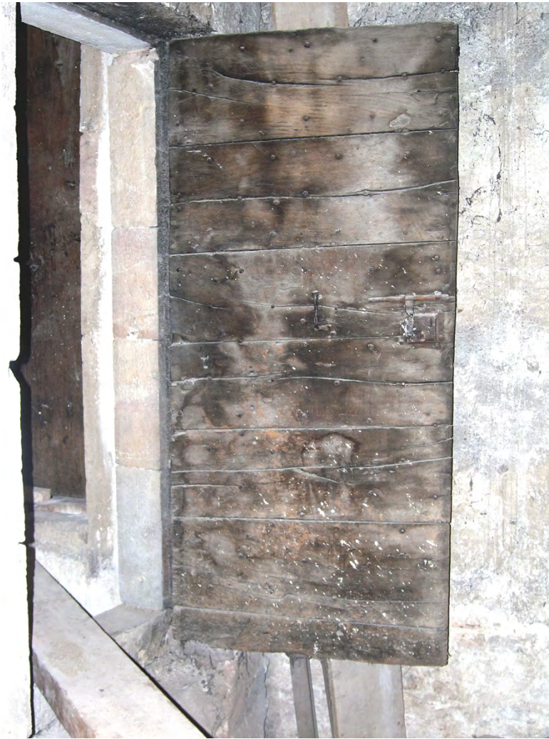
Abbildung 3.85: Haus 13, place Notre-Dame, Treppenturm um 1592, 3. OG. Türblatt um 1526 (d), gegen 1600 beschnitten und im obersten Geschoss des damals neu errichteten Treppenturms wiederverwendet.
