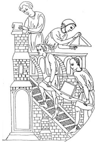
Abb. 1.6: Baustelle mit Laufschräge, Trage, Lotwaage, um 1225 (Glasmalerei im nordöstl. Chorungang der Kathedrale von Chartres).
