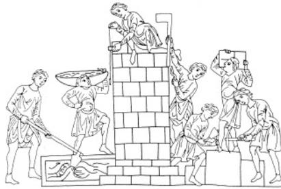
Abb. 1.8: Turmbau zu Babel, Steinmetzen mit Lot, Richtscheit, Doppelspitze, Schlageisen und Klöpffel sowie Mörtelmischer mit Mischhacke (Herrad von Landsberg, *Hortus deliciarum*, fol. 27, verbrannt).
