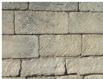
Abb. 3.10: Opus quadratum Kalkstein, Flächen gespitzt (W. Osthues).
