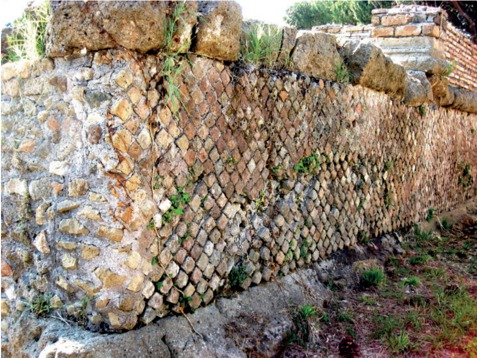
Abb. 3.9: Opus reticulatum an Unterbau des ‚tempio repubblicano‘ in Ostia, Mitte 1. Jh. v. Chr. Links im Bild der Mauer Kern aus caementitium (W. Osthus).
