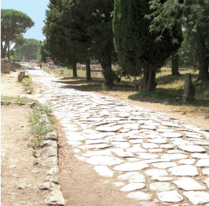
Abb. 3.32: Via Ostiense. Römisches Strassenpflaster (W. Osthues).
