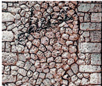
Abb. 3.8: Opus incertum am Unterbau des Tempels des Jupiter Anxur von Tarracina, heute Terracina (W. Osthuies).
