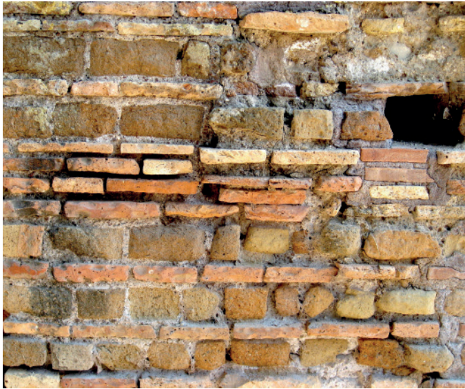
Abb. 3.12: Opus testaceum mixtum in Ostia. Abwechselnde Lagen von kleinen Tuffstein-Quadern und Ziegeln (W. Osthus).
