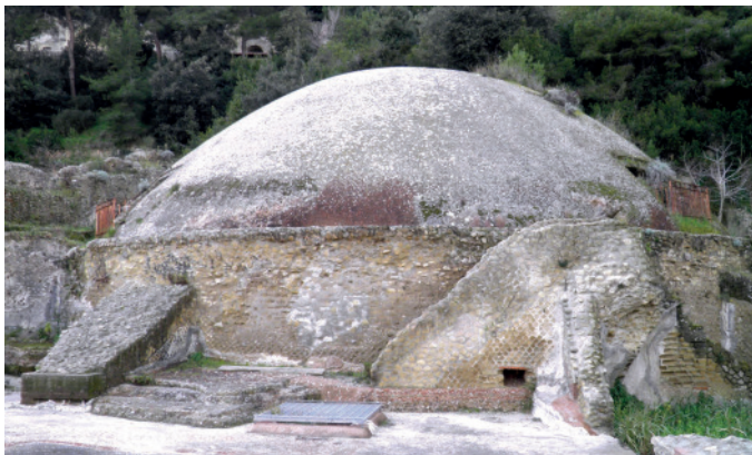
Abb. 3.28: Baiae, Mercurtempel. Links im Bild Strebepfeiler (W. Osthues).
