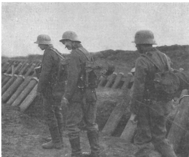
Leitungslegen am Gaswerfer, ca. 1915. (Quelle: Henrici 1931 , 564)
